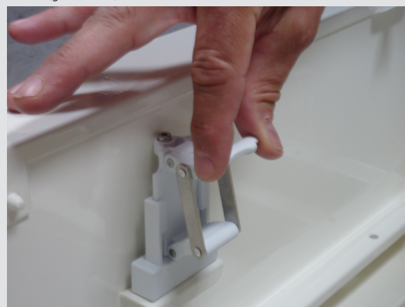
Système de serrage des filtres THE (grenouillère)
