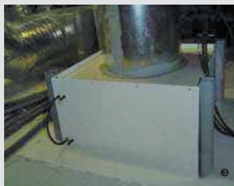
Système de serrage des filtres THE (grenouillère)
